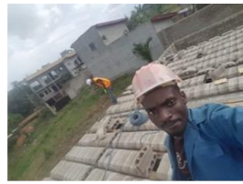
Jeune électricien installant une maison
