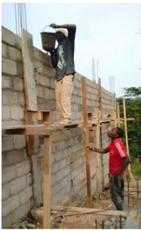
Des jeunes sur un chantier de construction de maison
